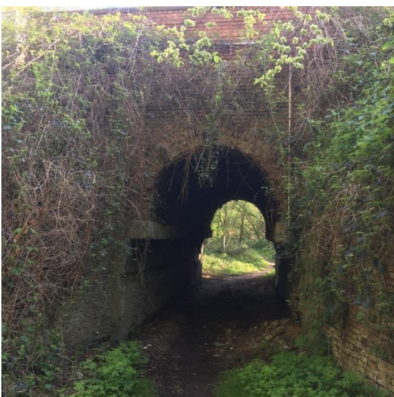
Tunnel onder Kapelstraat
