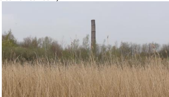
Schoorsteen machineconstructieplaats Landuyt (R06)
