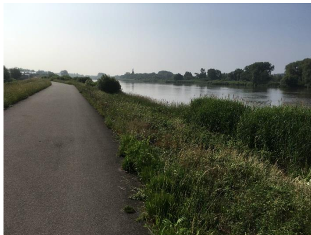
Bestaande situatie ter hoogte van kade Molleveld in oostelijke kijkrichting
