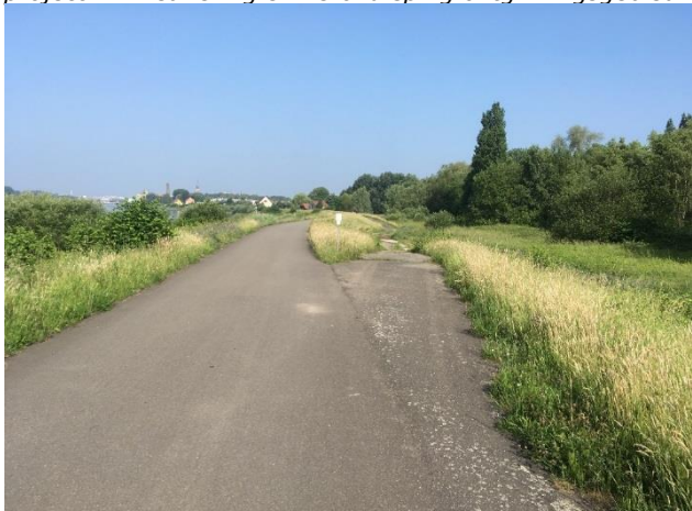
Bestaande situatie ter hoogte van kade Molleveld in westelijke kijkrichting
